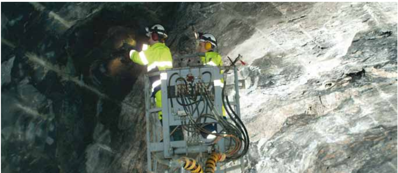
Geologit tutkivat tunnelin perää ONKALOSSA
