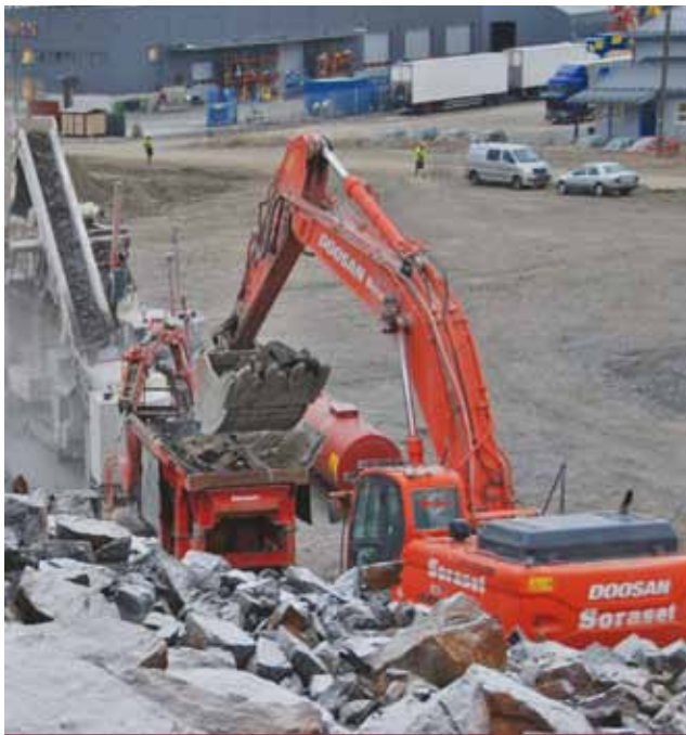
Työmaa alkoi asutuskeskuslouhintana
