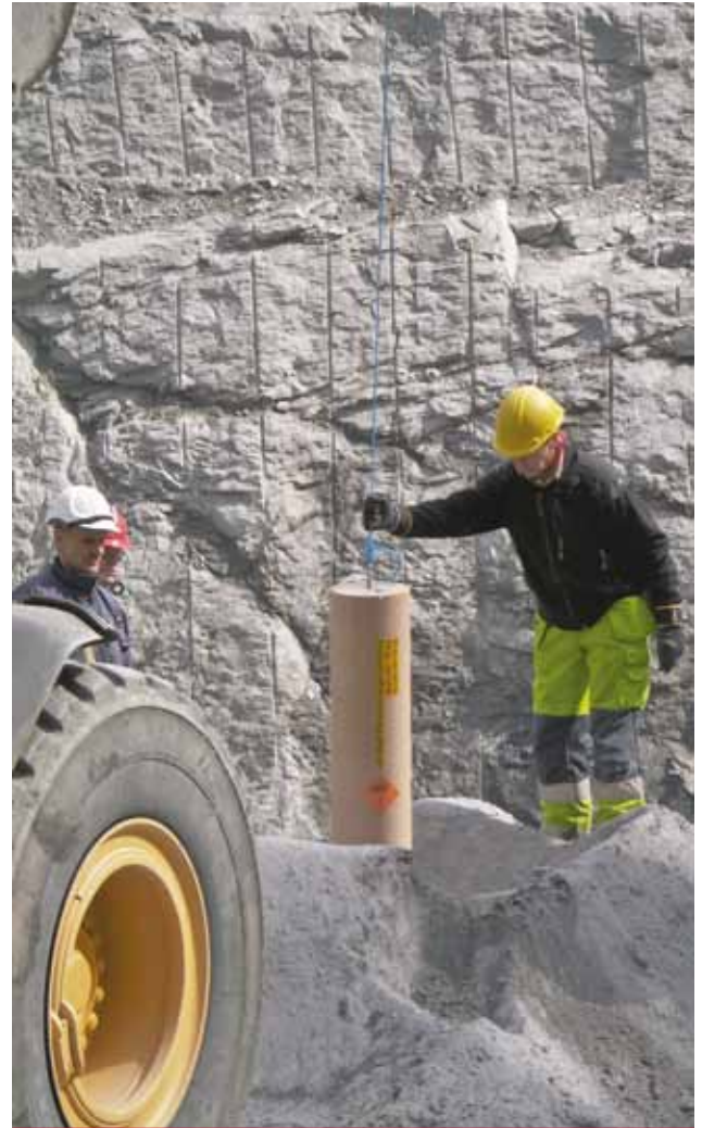
Osassa porareilissa käytetään varsin massiivisia lisäräjähdysainepanoksia
