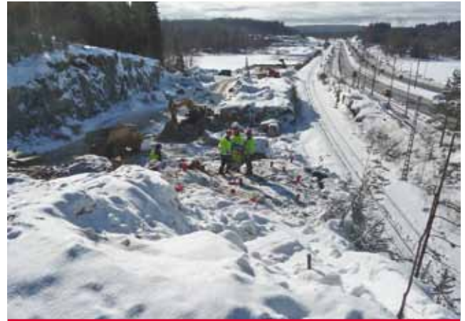
Kaakon Maanrakennus Oy:n panostajat työssään Vuorelan rampilla lähimmillään 5 metrin päässä pääradasta
